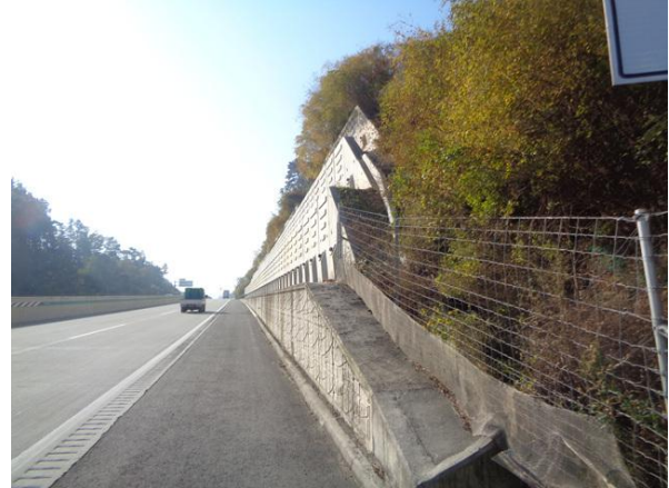
지반 기초부 상태양호
