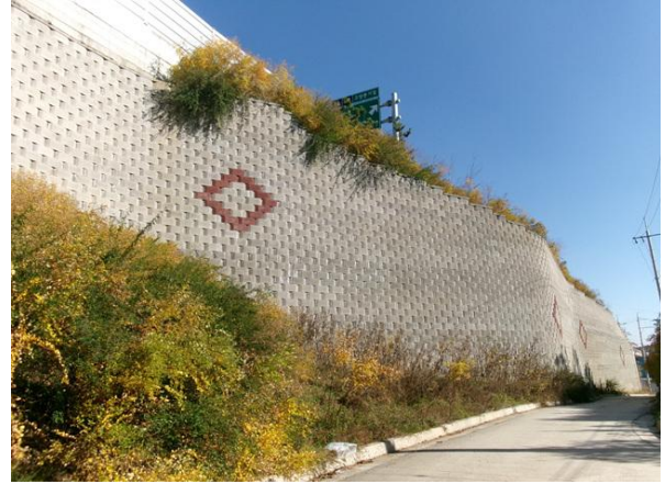
지반 기초부 상태양호
