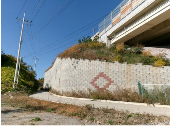
지반 기초부 상태양호
