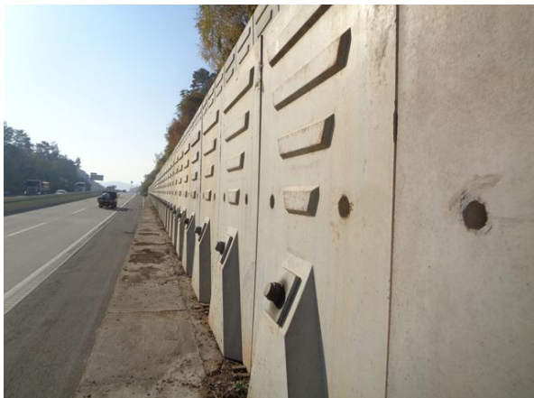
지반 기초부 상태양호
