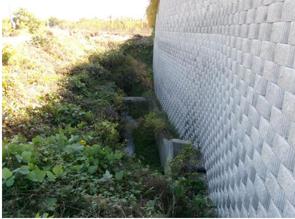
지반 기초부 상태양호
