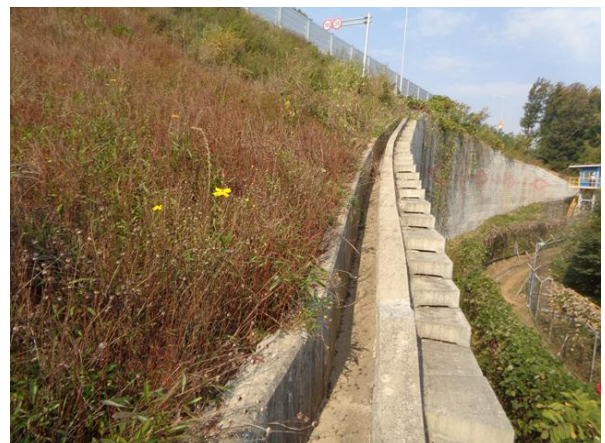
상부 성토부 전경
