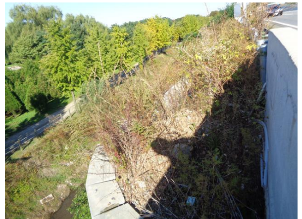
상부 성토부 전경
