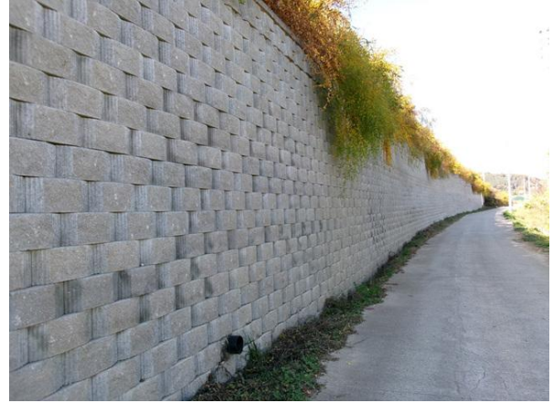
지반 기초부 상태양호
