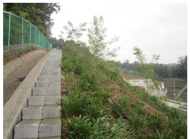
상부 성토부 전경
